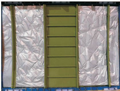
图4 隔声隔热层安装方式2
