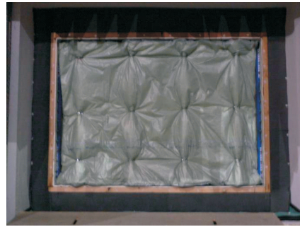
图5 隔声隔热层安装方式3
